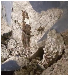
Photo : sondage GEOTEC déc.. 2023 - Aciers corrodés
